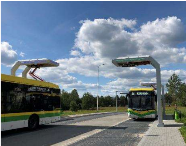
Rys. 4.3 Ładowanie autobusu elektrycznego akumulatorowego z ładowarki pantografowej w Zielonej Górze
