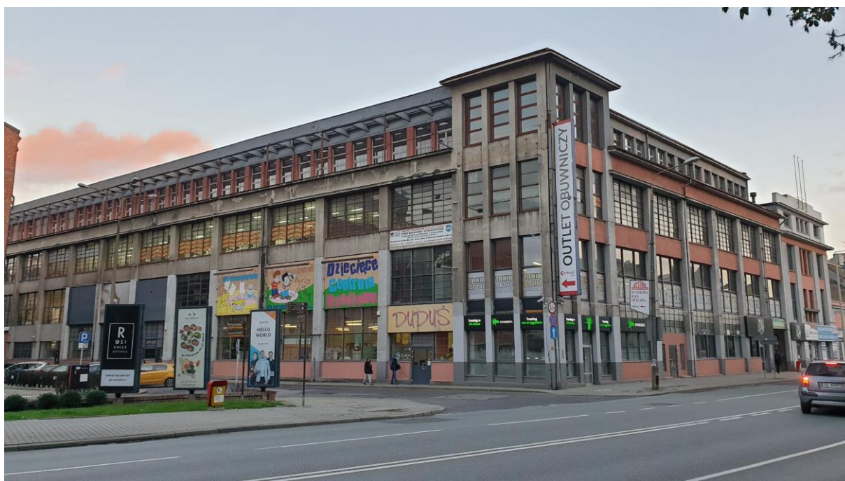
Fot. 1 Sklep przy ul. Powstańców Śląskich 6
