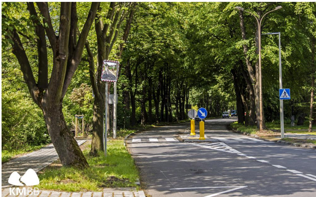
Rys. 9.8 Przykład bezpiecznego dojścia pieszego do przystanku autobusowego, doświetlonego oprawami LED, zgodnie ze standardami
