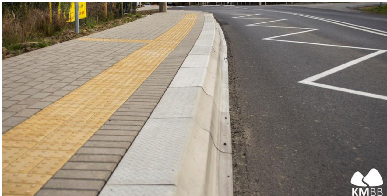
Rys. 9.6 Przykład peronu przystankowego wybudowanego zgodnie ze standardami
