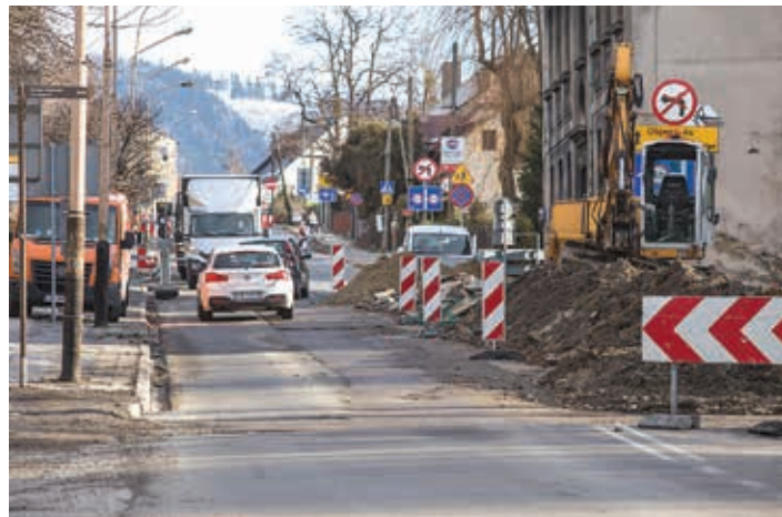
Prace na ul. Krakowskiej
