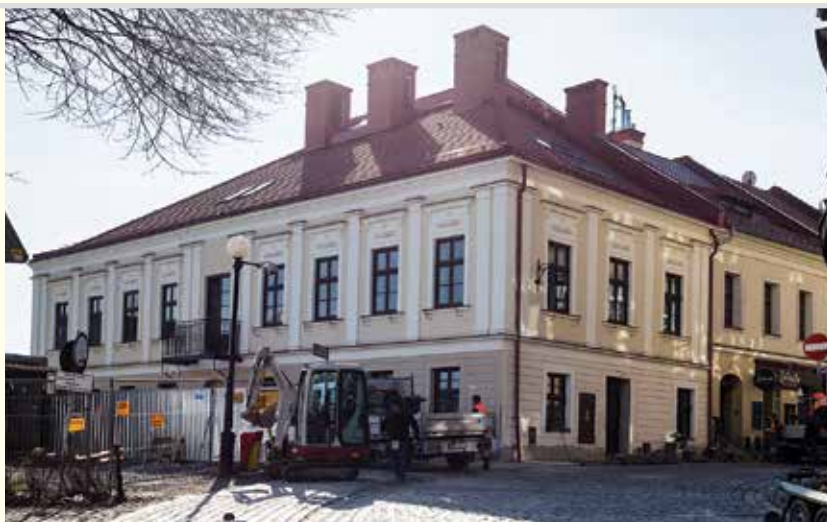
Budynek przy ul. Wzgórze 14
