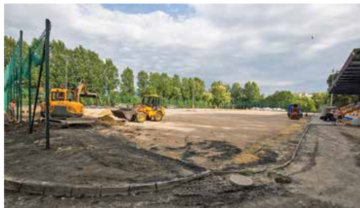
Prace na stadionie
