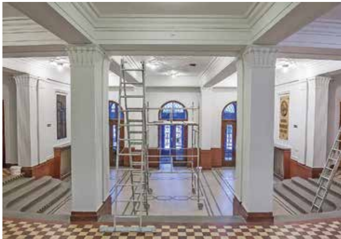
Remontowane wnętrza LO im. Kopernika
