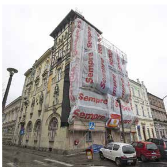
Remontowana kamienica Pod żabami
