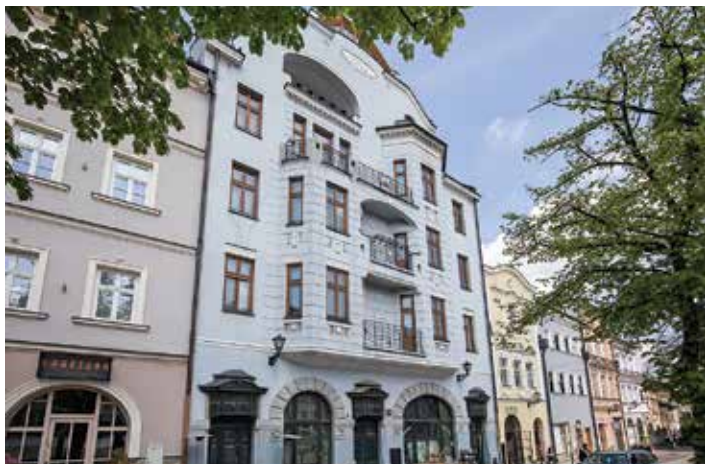
Kamienica przy Ryнку 11 będzie remontowana wewnątrz
