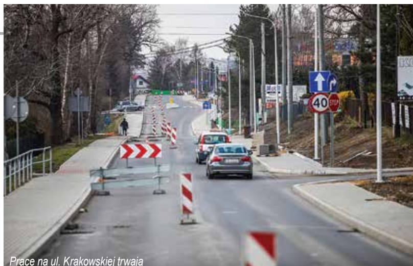
Prace na ul. Krakowskiej trwają
