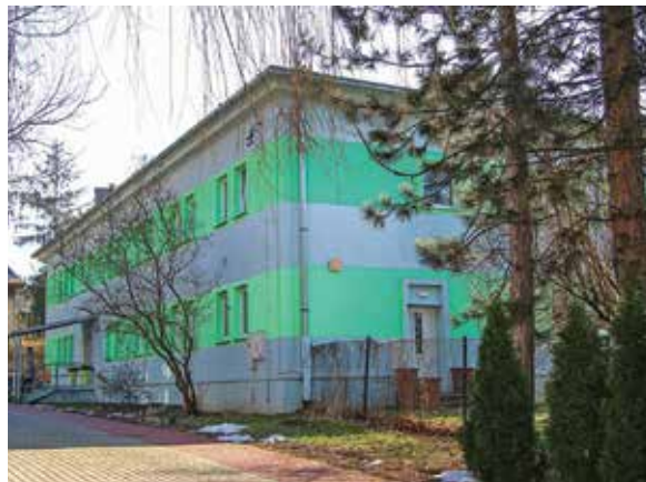
Istniejący budynek Przedszkola nr 4
