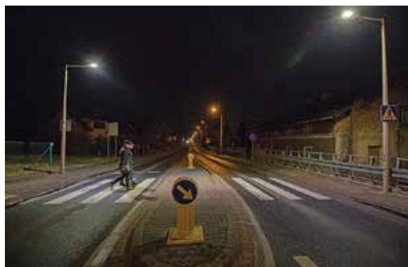
Doświetlanie przejść dla pieszych
