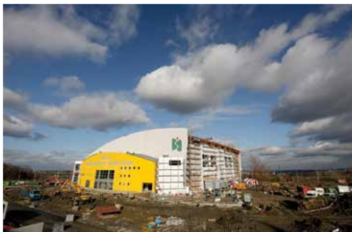
Powstaje hala widowiskowo-sportowa przy ul. Karbowej
