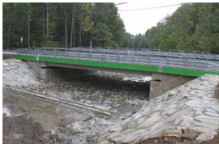
Most przy ul. Zapory
