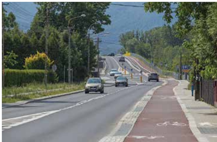
Wiadukt przy ul. Międzyrzeckiej
