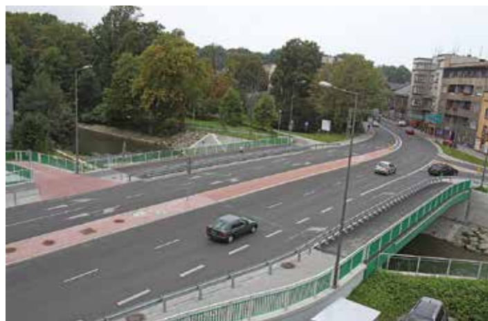
Nowy most drogowy w ciągu ulic PCK i 1 Maja
