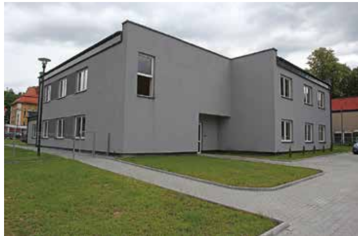
Bunkier radiologiczny przy Szpitalu Onkologicznym
