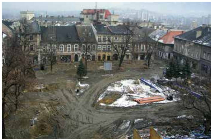
Rewitalizacja starówki – remont płyty Rynku
