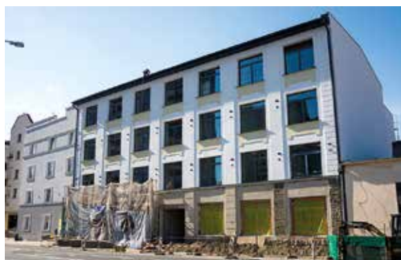
Fasada budynku przy ul. Dmowskiego
