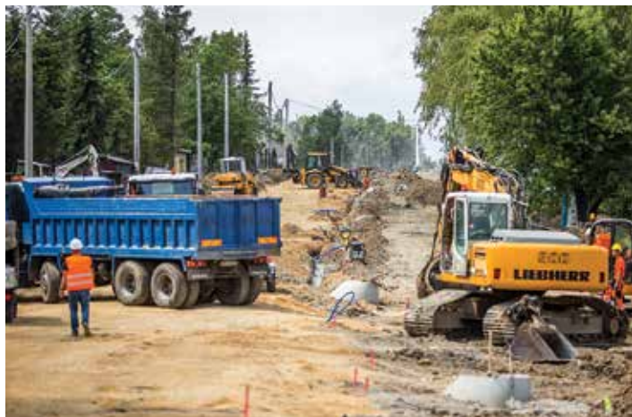
Prace na ul. Cieszyńskiej
