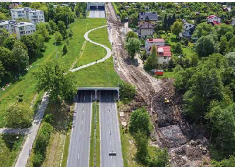
budowa łącznika przy Hulance
