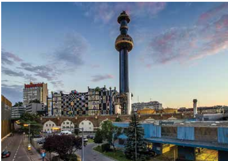
Spalarnia może być atrakcją turystyczną. Ten bajkowy obiekt to jedna z trzech spalarni działających w Wiedniu. Powstała w latach 70. ubiegłego wieku, obecny wygląd uzyskała w roku 1987. fot. pixabay
