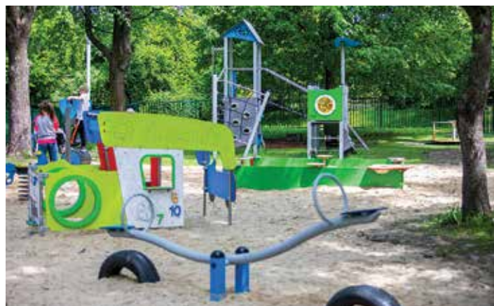
Rozbudowa parku jordanowskiego przy ul. Wyzwolenia
