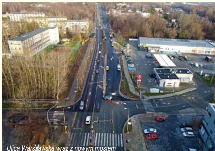
Ulica Warszawska wraz z nowym mostem
