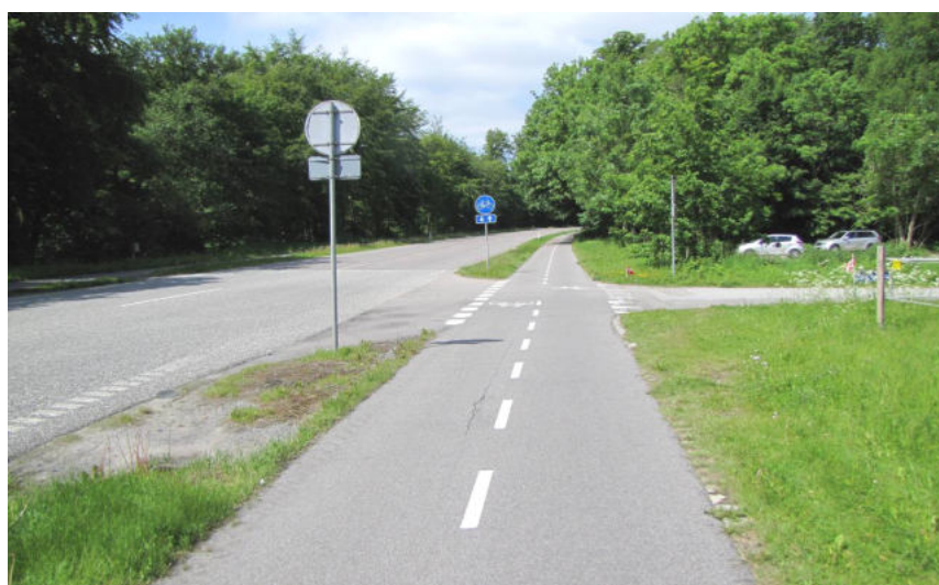
Fot. 7. Przykład 2 poprawnego przeprowadzenia drogi dla rowerów przez skrzyżowanie
