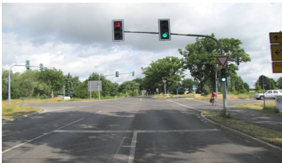
Fot. 6. Przykład 1 poprawnego przeprowadzenia drogi dla rowerów przez skrzyżowanie
