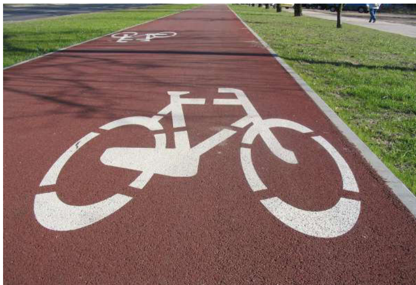
Fot.3. Rekomendowana nawierzchnia dla DDR
