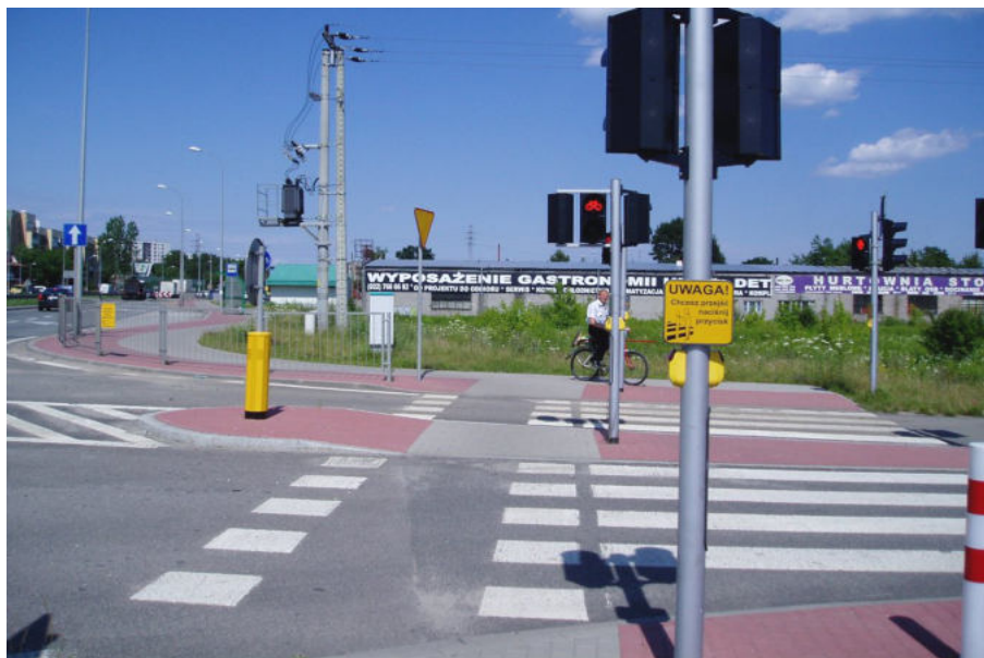
Fot. 5. Przykład błędnego odgięcia drogi dla rowerów ale także braku wyokrąglenia
