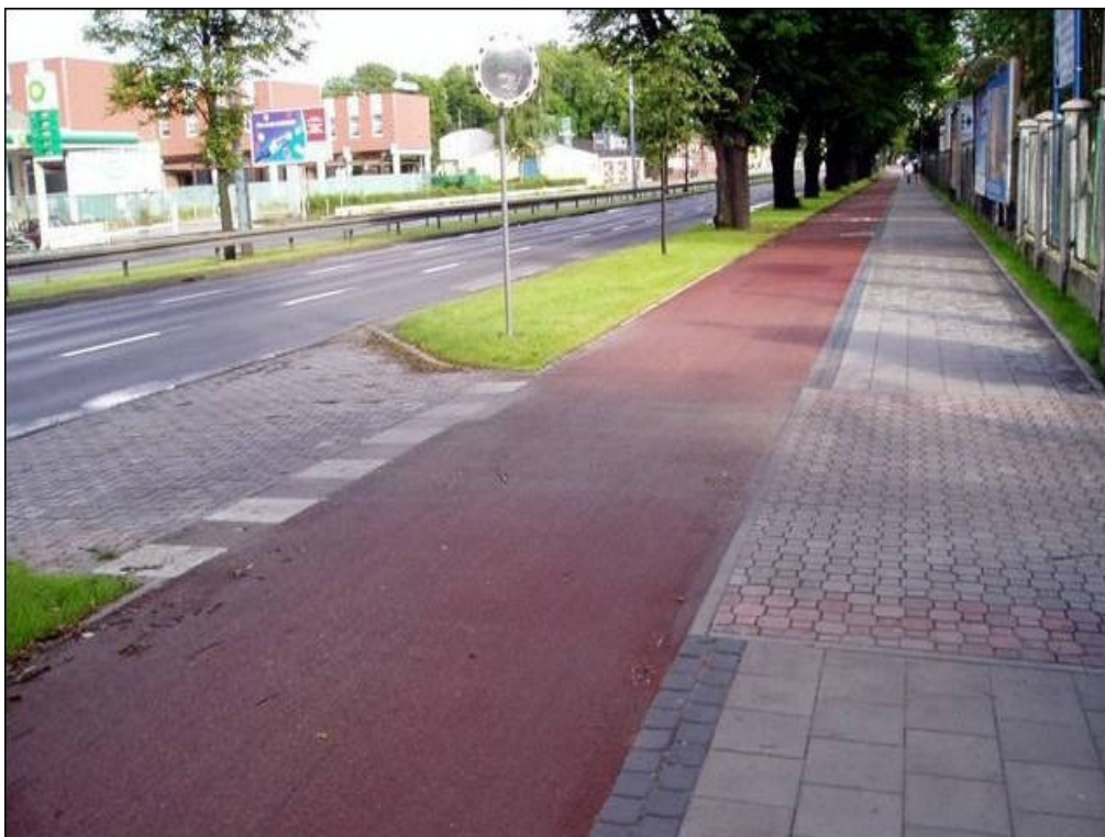
Fot. 2. Prawidłowo wykonana DDR, zachowana ciągłość nawierzchni DDR
