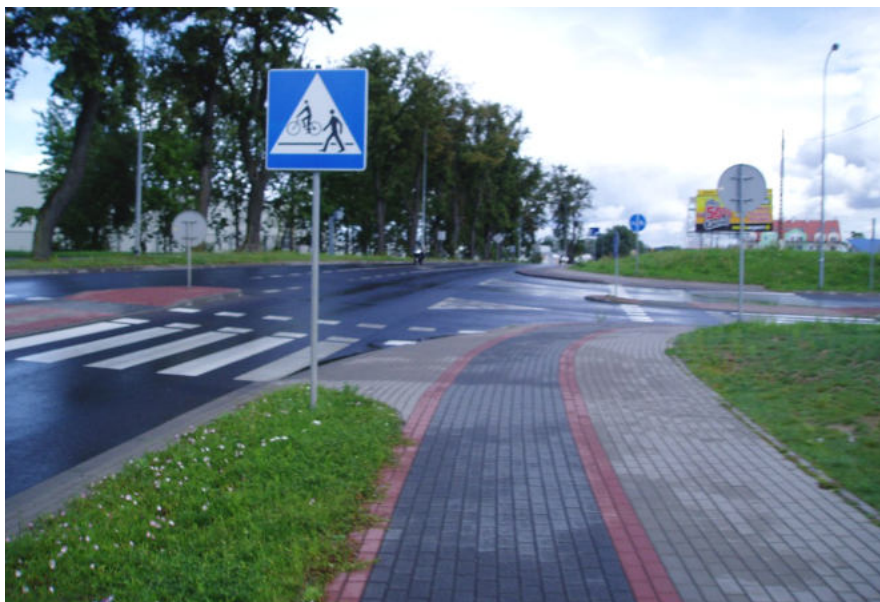
Fot. 4. Przykład błędnego odgięcia drogi dla rowerów
