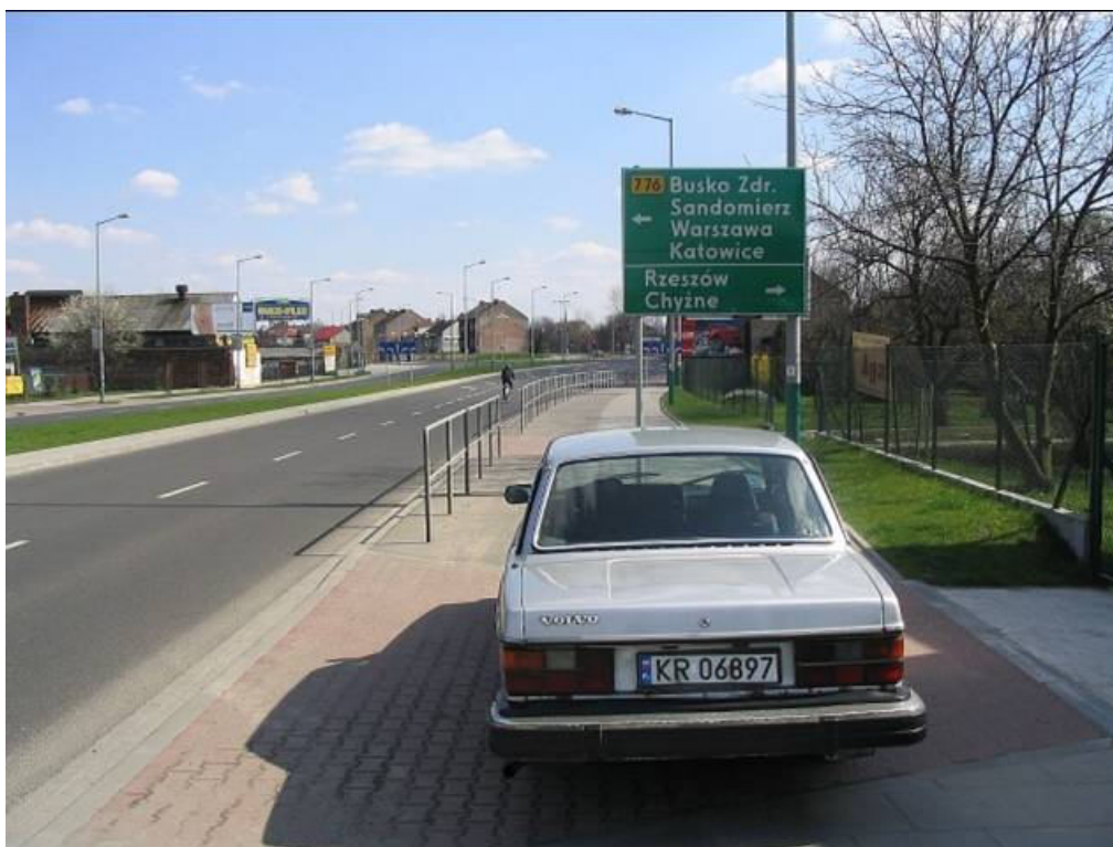
Fot.1. Nieprawidłowo wykonana DDR, brak ciągłości nawierzchni DDR
