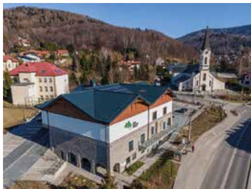
Budynek Domu Kultury w Straconce
