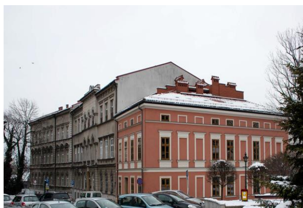
Lokalizacja: ul. Schodowa 2
