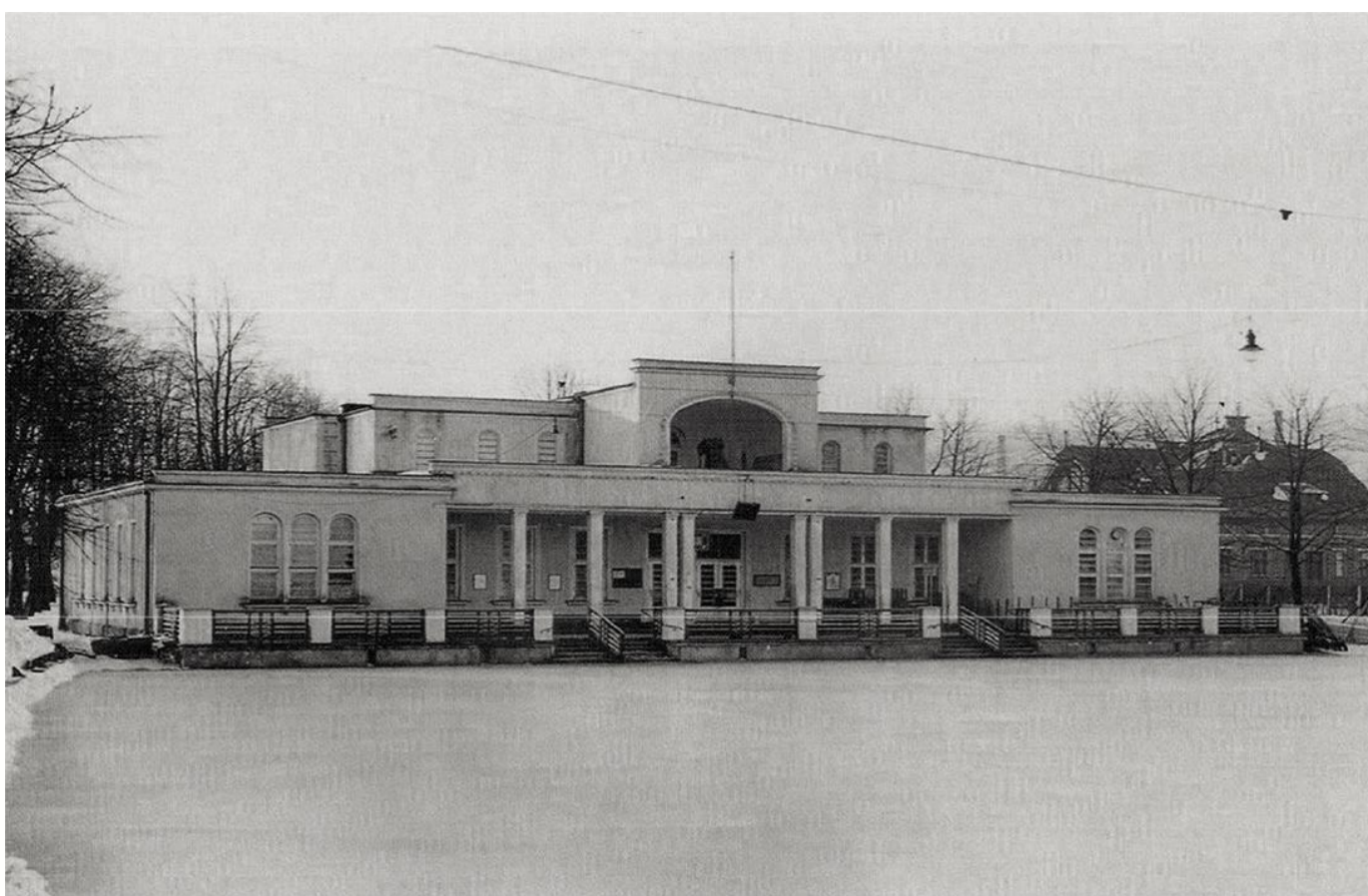
„Nowy” pawilon lodowy wybudowany po 1928 r. przez Towarzystwo Łyżwiarskie, arch. Alfred Widerman
