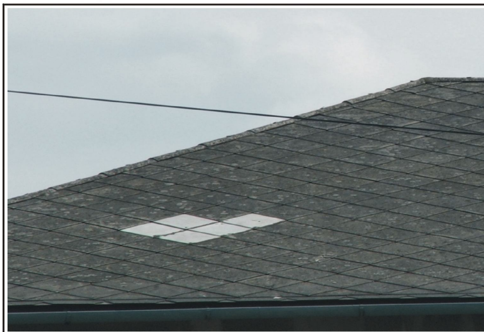
Fot.2 Pokrycie dachowe budynku mieszkalnego z płytek typu "caro" - II stopień pilności
