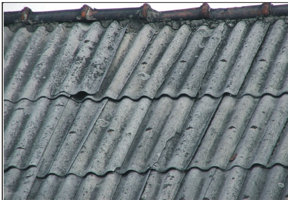
Fot.1 Pokrycie dachowe budynku gospodarczego z płyt falistych - I stopień pilności
