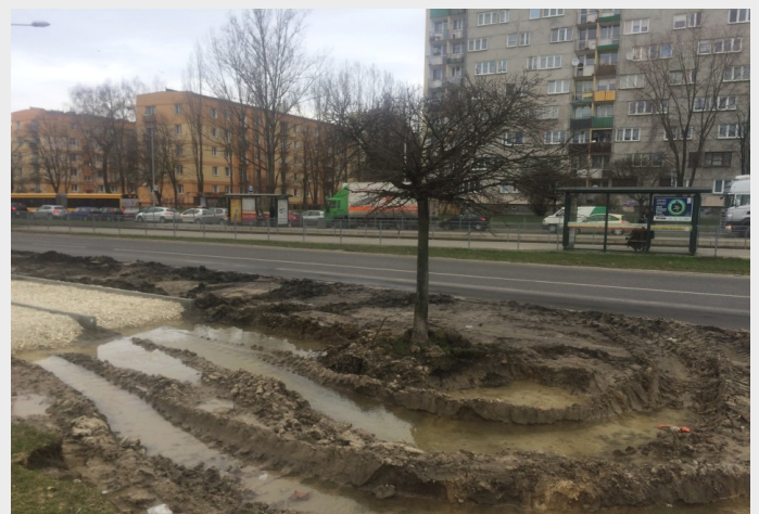
Wjazd ciężkich maszyn poza drogami tymczasowymi oraz zalanie w SOD
