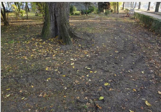
Wjazd ciężkich maszyn poza drogami tymczasowymi oraz zalanie w SOD
